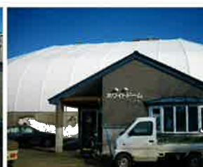
屋内ゲートボール場
